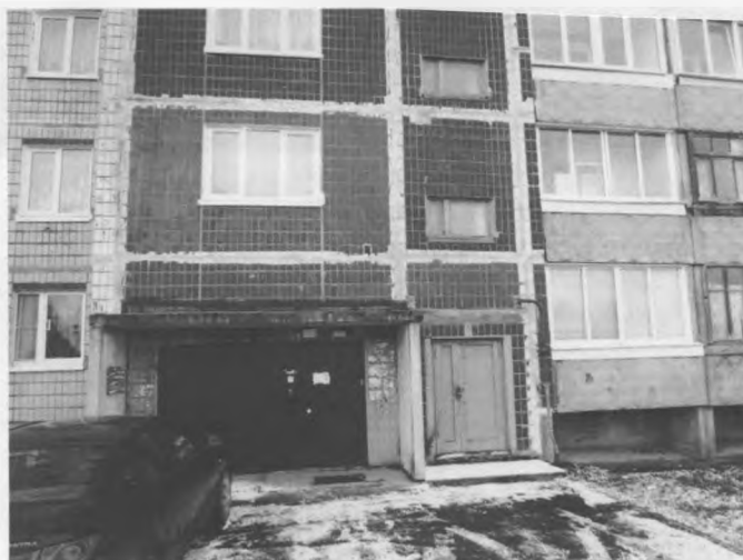
Фотография 2. Вход в оцениваемое помещение.
