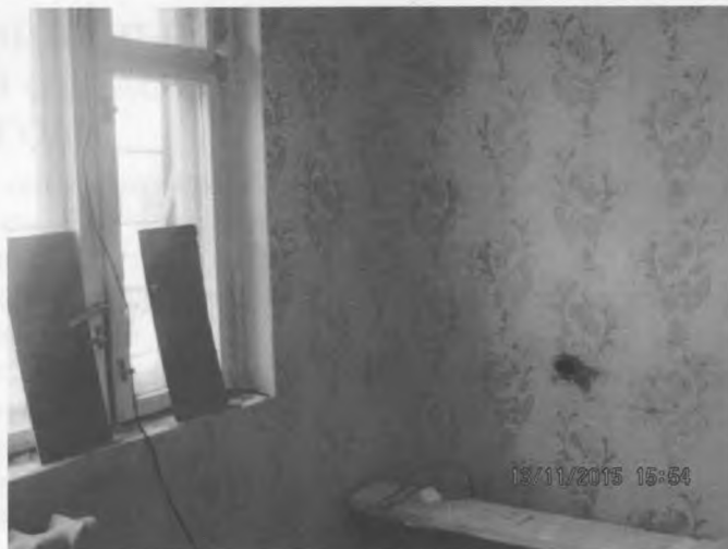
Фотография 4. Состояние внутренней отделки оцениваемого объекта.
