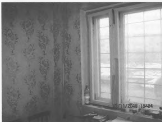
Фотография 5. Состояние внутренней отделки оцениваемого объекта.
