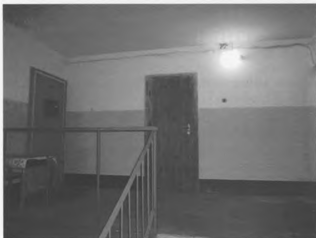
Фотография 3. Вход в оцениваемое помещение
