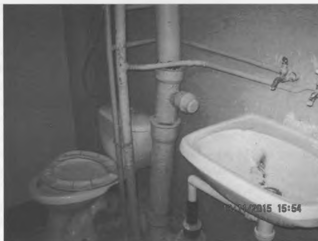
Фотография 6. Состояние внутренней отделки оцениваемого объекта.
